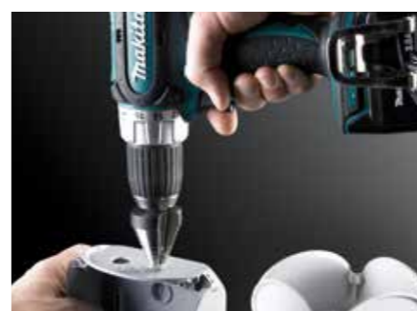
Alternative vegger uten knockouts for manuell kabelgjennomføring
