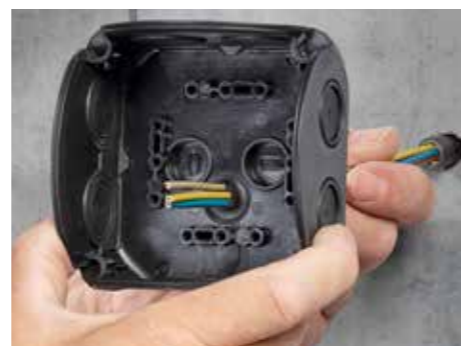
Kabelinnføring gjennom bunnen
