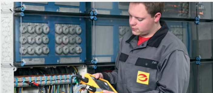
Energifordeler opptil 630 A som energi-koblings- og kontrollanlegg (PSC) etter IEC 61439 del 2
