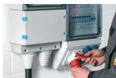
Koblingsboks for kontaktenheten, trykknapper eller brytere under tilbehør
