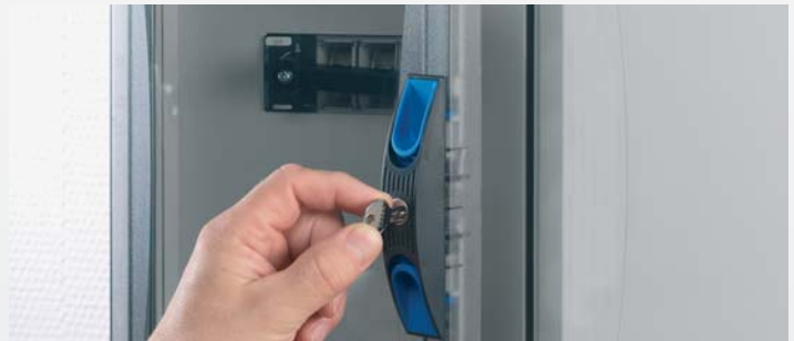
Betjening av utstyr bak dør med berøringsbeskyttelse
