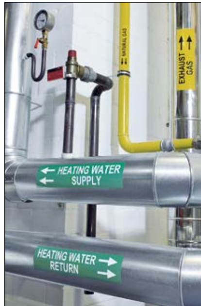
Stor og meget synlig merking av rør.
