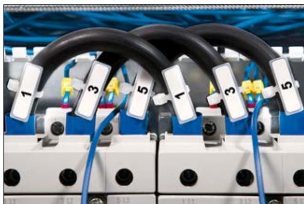
Med IT-bånd bunter og merker du i en arbeidsoperasjon.
