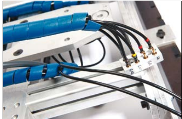
Sporbar spiralslange med metallinnhold for beskyttelse av kabler og ledninger i næringsmiddelindustrien.
