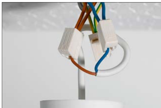
Rask installasjon av belysningsanordning med HelaCon Lux.
