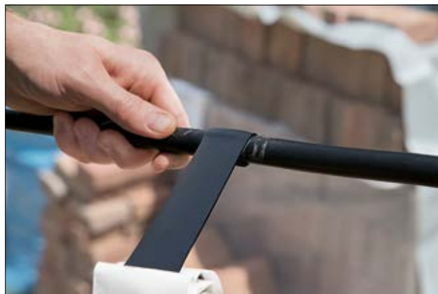
HelaTape Power 650 selvvulkaniserende isoleringsmasse er meget fleksibel.
