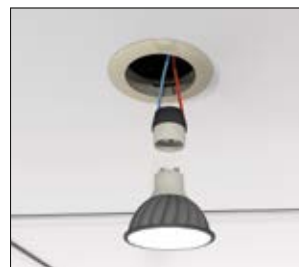
3. Koble lyskilden og lås den i korrekt posisjon.
