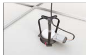
4. Koble downlighten til strøm, og fest kabelen gjennom øyet.
