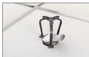
3. Monter downlighten iht. produsentens veiledning.
