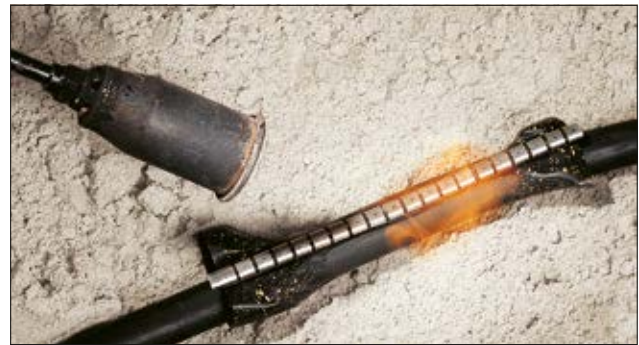
RMS for rask og sikker kabelreparasjon i felten.
