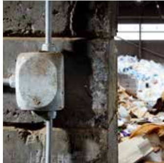
DK-serien: IP 66 for beskyttet installasjon elastiske tetningsmembraner eller metriske svekninger
