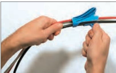
Kablene plasseres i monteringsverktøyet åpning.
