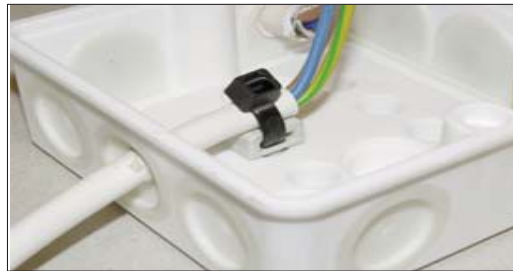
Kabler festes enkelt i strekkavlastningene med buntebånd.
