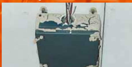
Koblingsbokser med tilkoblede kabler etter testing
