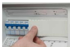
Avdekningsstrimmel til lukking av ubrukte utstyringsåpninger
