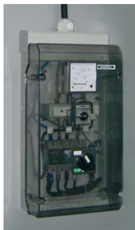
KV tom skap med utstyr
